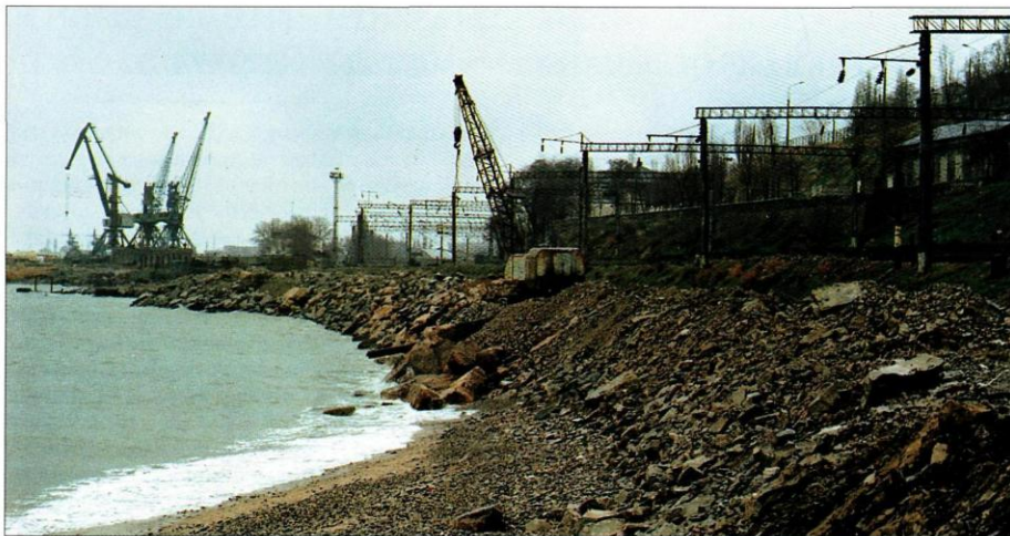
Работы по защите железной дороги от наступления моря в Махачкале, Россия (РОСТИДПРОМЕТ)
