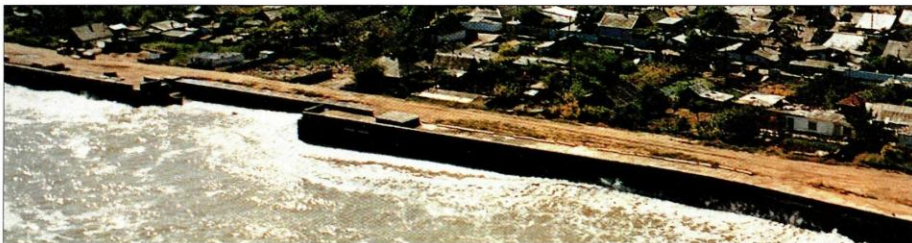
Береговые защитные сооружения в Дербенте, Россия (РОСГИДРОМЕТ)
